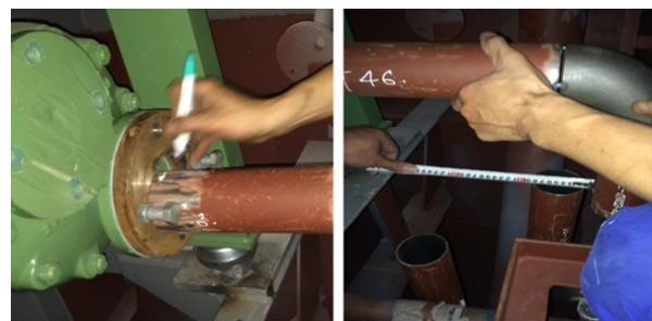
Рис. 6. Проведение измерения фактических отклонений по месту
