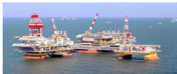
Рис. 1. Объекты месторождения им. В. Филановского (1-я очередь)
